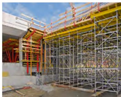
Modulare Traggerüstlösung mit PERI UP Rosett für Stielasten bis zu 40 kN, eingesetzt bei diversen Anschlussbauwerken.
