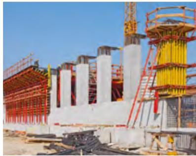
Beim Bau des über 3 km langen Umweltschutztunnels erfüllten wirtschaftliche Systemlösungen mit mietbaren Baukastensystemen die unterschiedlichsten Anforderungen.
