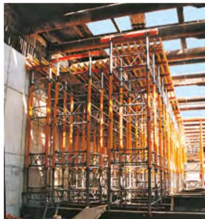
MULTIPROP Türme, Stahlriegel und Gitterträger GT 24 als Flächentraggerüst für die Decke.
