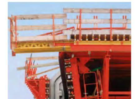
Der Tunnelbau erfolgte im „Einschwimm- und Absenkverfahren“ – einer in Deutschland kaum bekannten Technologie.
