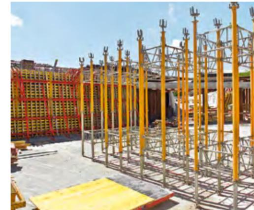
Tragfähig kombiniert: Mit MRK Rahmen zu Lasttürmen verbundene MULTIPROP Deckenstützen unterstützten die nachfolgend aufgelegten GT 24 Doppeljoche.
