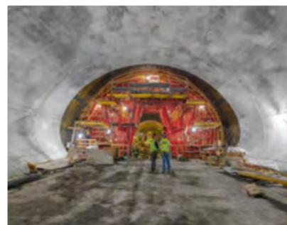
Die projektspezifische Lösung zu Ausführung der Innenschale basierte auf einem verfahrenen Tragwerk aus Systembauteilen des VARIOKIT Ingenieurbaukastens.
