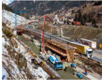
Mithilfe der VARIOKIT Tunnelschalungslösung konnten 25 m lange Abschnitte des Tunnelgewölbes im regelmäßigen 4-Tages-Takt betoniert werden.
