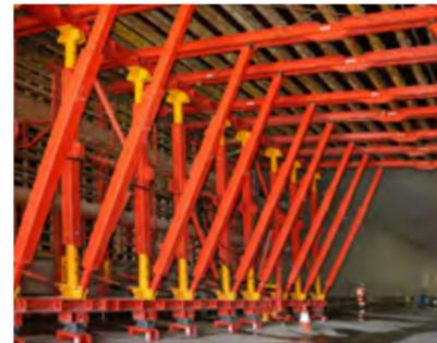
Mit einem maßgeschneiderten VTC Tunnelschalwagen, bestehend aus Standardbauteilen des VARIOKIT Ingenieurbaukastens in Kombination mit GT 24 Trägern und Latten in unterschiedlichen Längen, konnten die Projektanforderungen erfüllt werden.
