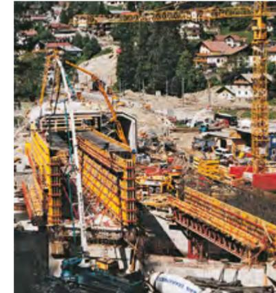
Die Umrüstung der VARIO GT 24 Träger-Wandschalung im Bereich der polygonal gekrümmten Tragwerkswand (links) auf die geraden Wände (Abschnitt rechts) erfolgte durch den Austausch von Gelenkkupplungen gegen starre Kupplungen. So musste nicht das gesamte Element umgebaut werden.
