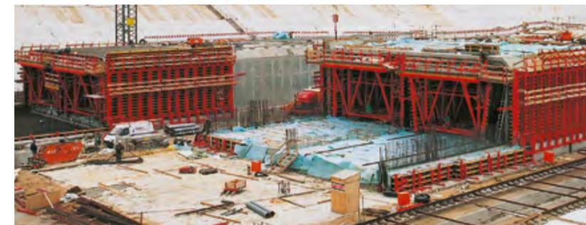
Fugenbänder in den Arbeits- und Taktfugen sorgten für Wasserundurchlässigkeit.
