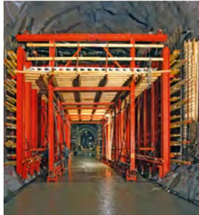
Wand- und Deckenschalwagen waren derart konzipiert, dass der Baustellenverkehr jederzeit ungehindert passieren konnte. Lediglich während des Betoniervorgangs mussten Lieferungen unterbrochen werden.
