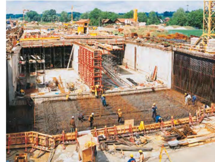
Die Übersicht zeigt die drei Betoniertakte sehr deutlich: nachdem Sohle und Wand in einem Guss hergestellt wurden, betonierte das Baustellenteam die Mittelwand und abschließend die Deckenplatte.
