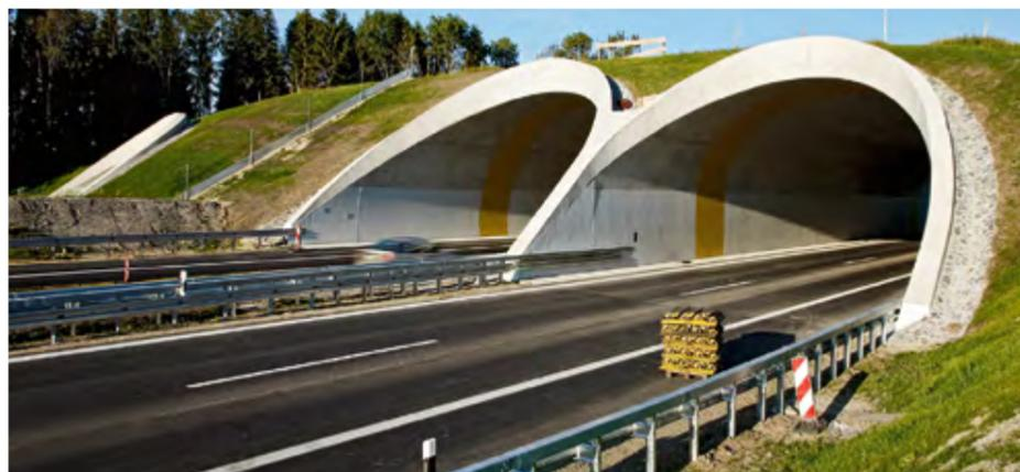
Die Doppelröhre über der A96 wurde mittels zweier Tunnelschalwagen aus Systembauteilen des VARIOKIT Ingenieurbaukastens hergestellt.
