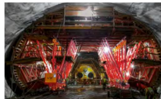
Bei der Anpassung an die Querschnittsänderung ließen sich die patentierten Teleskopsteher mit wenigen Handgriffen sehr schnell auf die richtige Länge einstellen.
