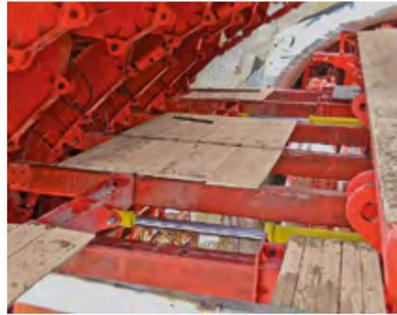
Das nach oben geöffnete Schalungssegment und der Hydraulikzylinder für die horizontale Verschiebung.
