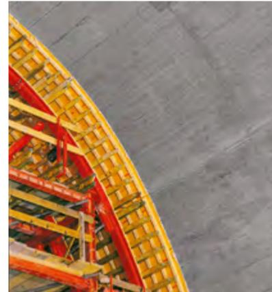
Der Schalungsaufbau bestand aus einer 27 mm 3-S-Platte, Gitterträgern GT 24 als Verteiler und einer Gurtung aus gebogenen HEB 160 Stahlträgern.
