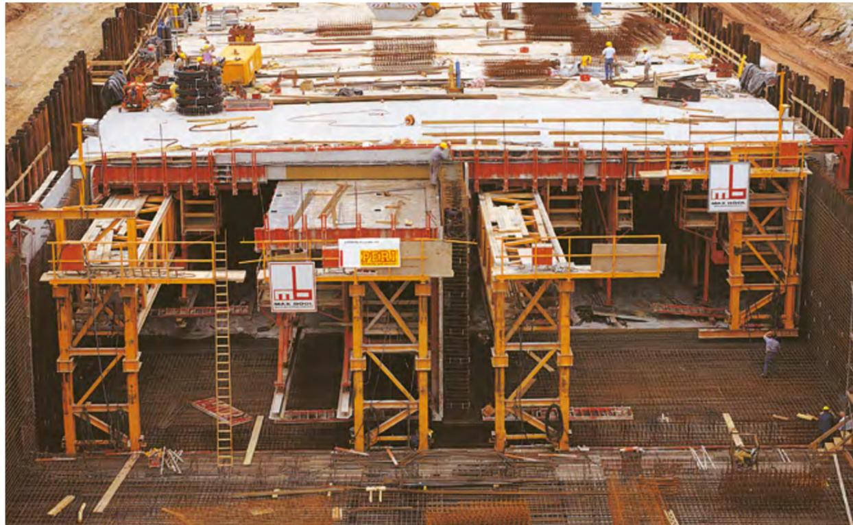
Für die B93 in Mosel (Zwickau) wurde ein 450 m langer Tunnel in Tieflage und offener Bauweise errichtet. Die Ein- und Ausfahrampen waren als offene Betontröge herzustellen. Aufgrund der extrem knappen Terminvorgaben wurde der Tunnel in 10 m-Woche-takten im monolithischen Bauverfahren
