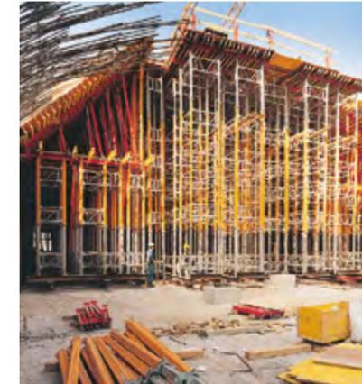
Die alu-leichten MULTIPROP Türme aus dem PERI Mietpark waren schnell montiert und trugen die Lasten der 10,50 m hohen und 1,20 m starken Tunneldecken sicher ab.
