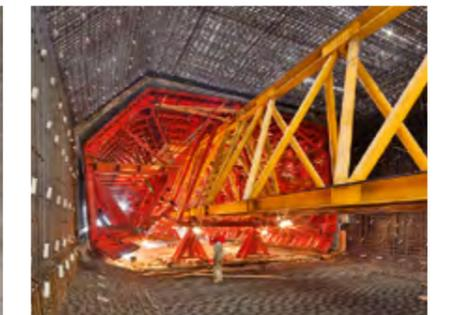
Die Innenschalung fährt hydraulisch über Vorschubträger in die Bewehrungskörbe und somit in Betonierposition ein.
