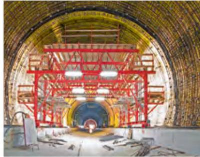
Ein Teil des Ausbaus der Eisenbahnlinie 320 von Mosty nach Jablunkova ist die Sanierung des Jablunkova Tunnels. Das Bauwerk ist für eine zweispurige Schieneführung ausgelegt und insgesamt 612 m lang. Auf einer Länge von 564 m wurde der Tunnel in bergmännischer Bauweise mit einem Gefälle von 0,2% ausgeführt, bei den Portalen wurde die offene Bauweise angewendet.
