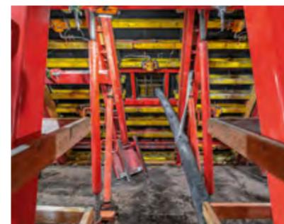
Um das Tragwerk sicher im Gleichgewicht zu halten, wurde auf beiden Seiten abwechselnd Betoniert. An der Schalung montierte Rüttler stellten dabei die gleichmäßige Verteilung des Betons sicher.
