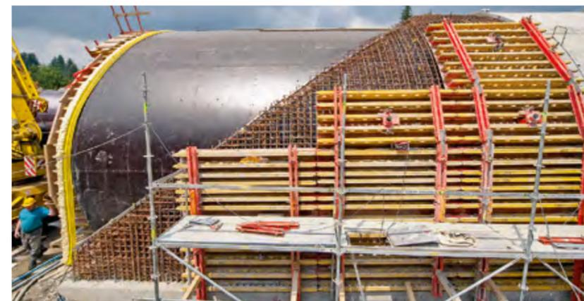
Für den Abtrag der vertikalen Lasten wurden Schwerlasttürme ST-A4 eingesetzt.
