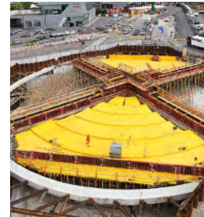
Die komplexe Bauaufgabe mit bis zu 2,70 m hohen Unterzügen und 1,20 m starken Stahlbetondecken erforderte eine umfassende Schalungslösung.
