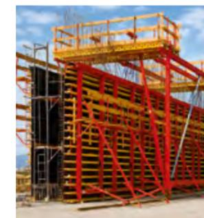
Die beiden PERI Schalwagen für die vorlaufende Mittelwand waren ohne Kranunterstützung umsetzbar.
