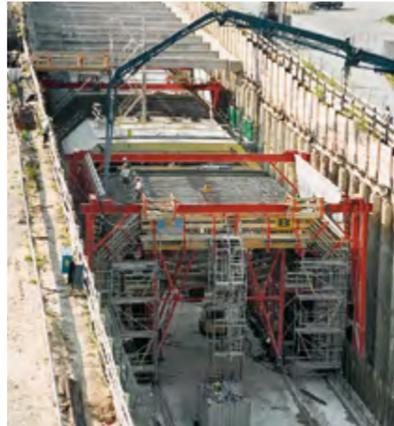
Die Herstellung des Tunnels erfolgte in einer 12 bis 20 m tiefen Baugrube, die durch eine rückverankerte, aufgelöste Bohrpfehlwand mit aussteifender Sohle und zum Teil mit Kopfaussteifungen gesichert war.
