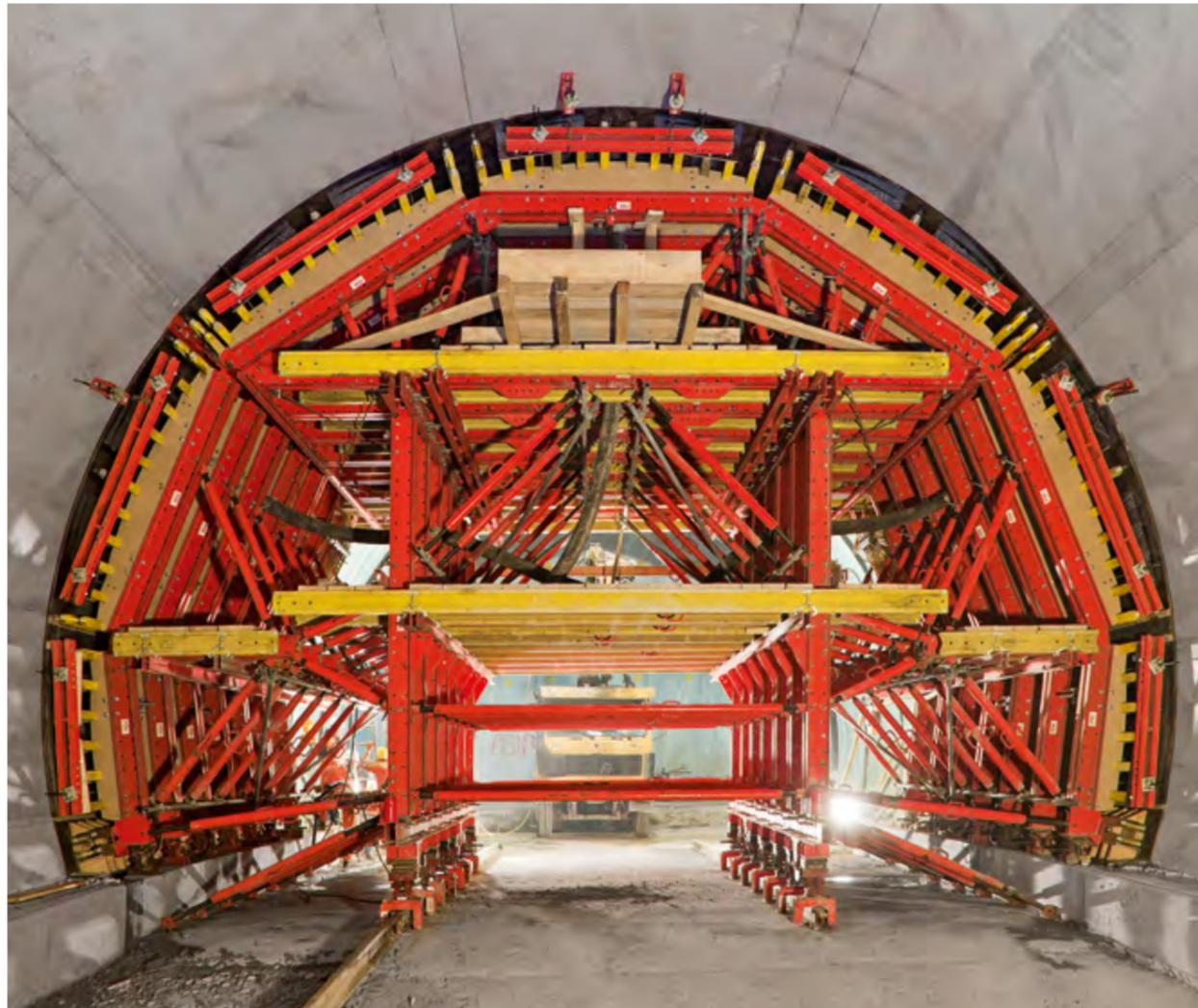
**PERI plante, konzipierte und lieferte einen Tunnelschalwagen auf Basis mietbarer Systembauteile in kürzester Zeit. Die Abwicklung verlief reibungslos, die Formstabilität resultierte in sehr guten Betonergebnissen.**
