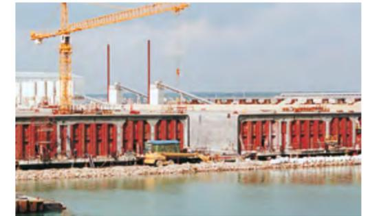
Zwei 176 m lange Tunnelteilelemente im gefluteten Becken, bereit zum Verschleppen in ihre Endposition.
