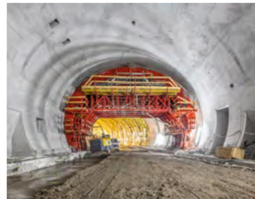
Für das Bauunternehmen hatten bei der Projektausführung lösungsorientierte und kooperative Arbeitsmethoden oberste Priorität. So entwickelten PERI Ingenieure den ersten maßgeschneiderten und vollhydraulischen Sonderstahlschalwagen mit Raupenantrieb und einem Gewicht von 250 t für Österreich. Dieser allein genügte, um die verschiedenen Querschnitte in insgesamt 170 Betonierabschnitten herzustellen.
