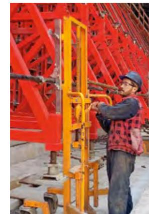
Auf 5,40 m aufgestockte TRIO Elemente mit Stützböcken SB-A und SB-B vor dem Betonieren.
