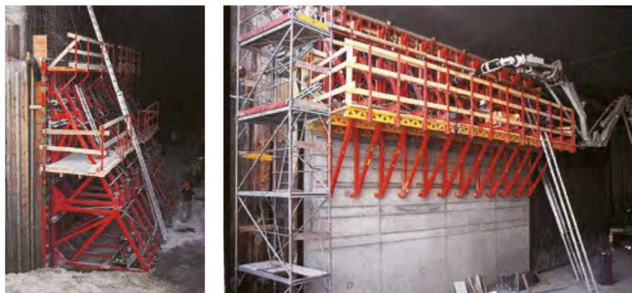
Im Bereich des Süd-Portals weicht die Wandhöhe vom Regelquerschnitt ab. Die maximale Höhe von 9,60 m wurde in zwei Etappen betoniert: Bis zu einer Höhe von 6,55 m wurden Stützbock- und TRIO Rahmenschalungselemente eingesetzt, für den zweiten Betonierabschnitt TRIO Elemente auf SKS 180 Kletterkonsolen.
