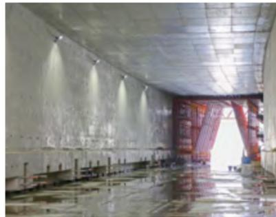
Mithilfe des eingesetzten VTC Tunnelschalwagens konnten sowohl Untersichten als auch Innenplatten schnell und sicher gleichzeitig ausgeschalt werden.
