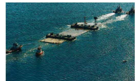
Transport eines 57.000 t schweren Tunnelteilstückes über das offene Meer.
