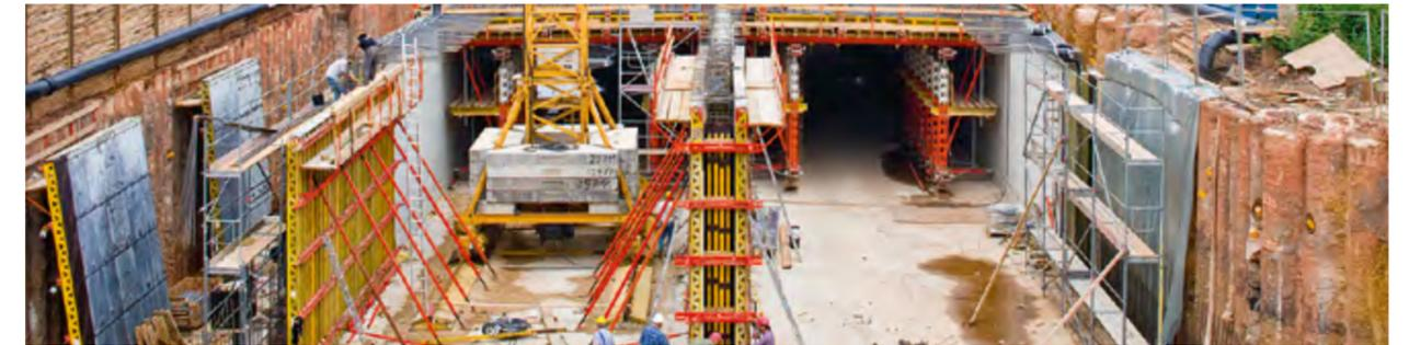
Der Tunnel wurde in aufgelöster Bauweise hergestellt, die drei Hauptbauteile Sohle, Wände und Decken wurden also nacheinander betoniert.
