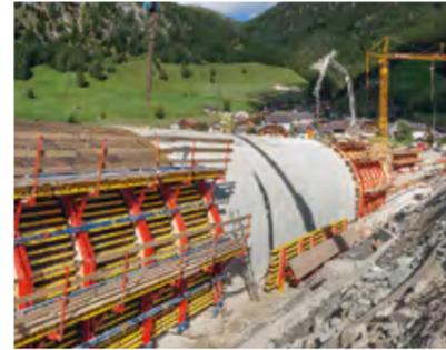
Die Außenschalung für das Tunnelgewölbe wurde in großflächigen Einheiten mit dem Kran umgesetzt.
