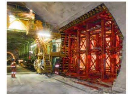
Auch die Anbindung des Querschlags an die neue Hauptröhre war Bestandteil der PERI Lösung – auf Basis von Systembauteilen wie SLS Schwerlastspindeln, RCS Schienen, GT 24 Schalungsträgern und SRU Riegeln. Eine Verankerung am Stahlschalwagen der Hauptröhre war nicht erforderlich.
