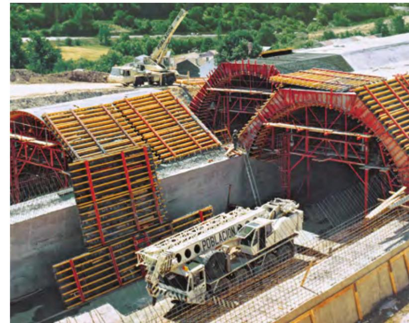
Für den Bau des Teilabschnitts über den Somosierrapass wurden insgesamt vier Schalwagen eingesetzt.
