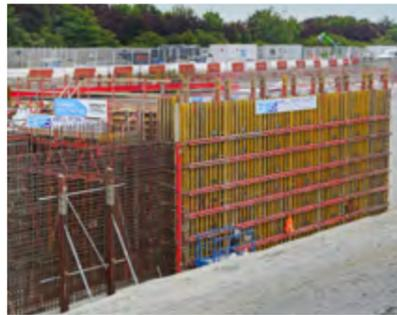
Insgesamt wurde der Tunnel in neun Betonierabschnitten, die jeweils 17 m lang und 8 m hoch waren, gegossen. Die Kombination aus Betonierreihenfolge sowie der hohen Geschwindigkeit des VTC Systems trugen dazu bei, pro Takt ganze zehn Tage einzusparen.
