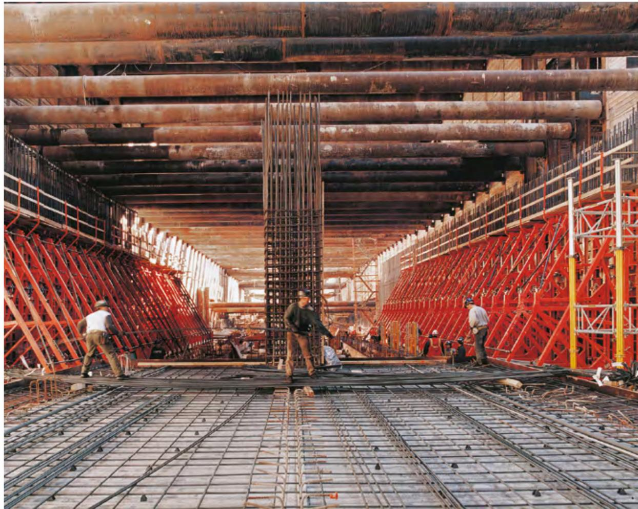
Die MULTIFLEX Tische mit MULTIPROP Unterstützung für den 600 m<sup>2</sup> großen Deckenabschnitt ließen sich in Einheiten von Takt zu Takt umsetzen.
