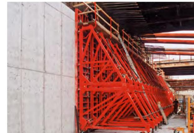
Eine optimale Verankerung ließ schnelle Betoniergeschwindigkeiten und 60 kN/m<sup>2</sup> Frischbetondruck zu.
