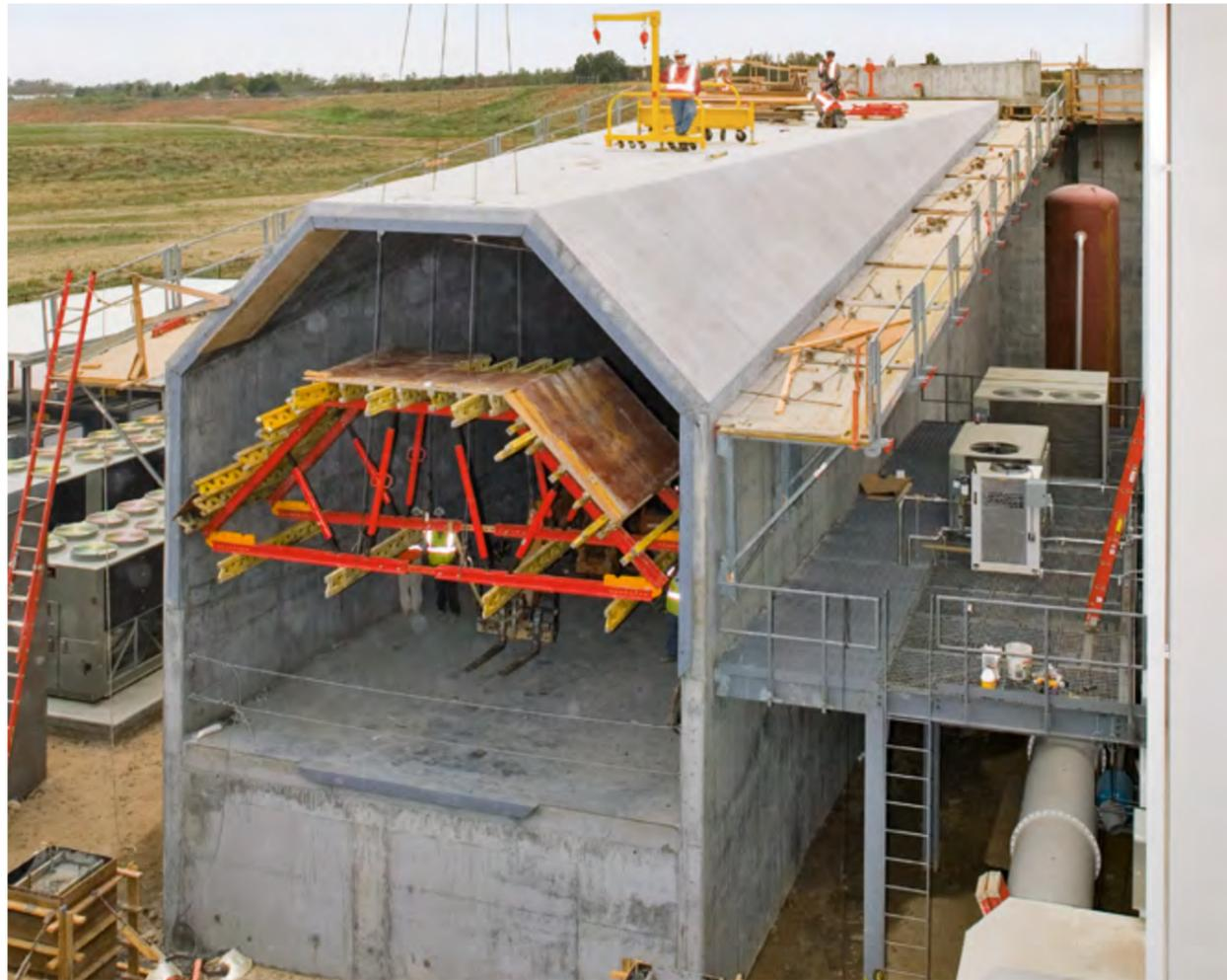
Der in Breite und Höhe veränderliche „back-leg diffuser“ konnte mit vormontiert angelieferten Gespärreeinheiten maßgenau geschalt werden – auf der Basis mietbarer PERI Standardsysteme.
