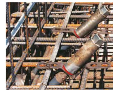
PERI V-Ankerhalter zum effizienten Einbau von Anker beim Einsatz von Stützböcken.
