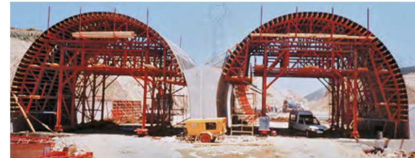
Die zweite Phase des Betonierabschnittes: Nach der Herstellung der Wände an der Außenseite sowie zwischen den beiden Tunnelröhren kamen die Schalwagen für das Doppelgewölbe zum Einsatz.
