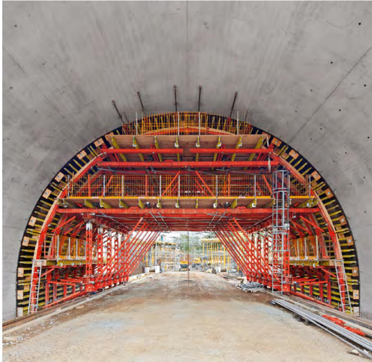
Wagenheber hoben den Schalwagen wieder in Betonierposition, anschließend wurden die Seitenelemente nach oben gespindelt. Nach dem raschen Einbau der Bewehrung mit hohem Vorfertigungsgrad setzte ein Mobilkran die Außenschalung um. Diese bestand je Seite aus nur zwei Elementen. 12 Betonierfenster dienten zum Einbau des Betons, die Verdichtung erfolgte über Innenrüttler. Schnell konnte –
