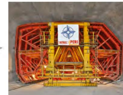
Die Tunnелеlemente werden in acht Einzelsegmenten von jeweils 22,50 m gegossen – ankerlos und unter Einhaltung strengster Maßtoleranzen.
