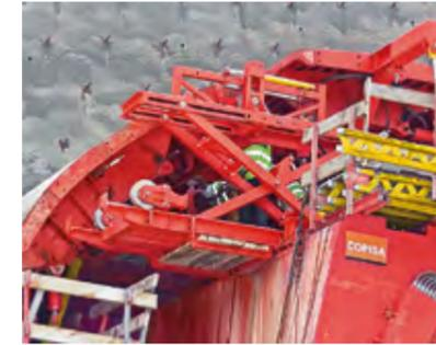
Zur Veränderung des Schalwagenquerschnitts wurden Schalungssegmente ergänzt. Sämtliche Umbauarbeiten konnten mit Hydraulikeinheiten ausgeführt werden.
