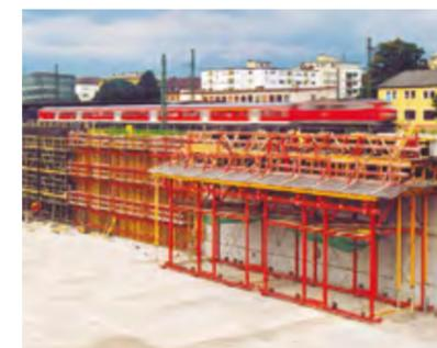
Bewehren mit PERI UP Gerüsteinheiten, Betonieren der Wände mit VARIO und Herstellen der Trogwand-Konsole mit dem Tunnelschalwagen.
