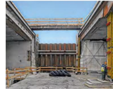
Die Schalungslösung berücksichtigte bei den Stirnschalungen sowohl Schubverzahnungen als auch zwei unterschiedliche Abdichtungsvarianten.
