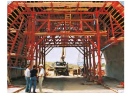
Für die Stirnabschalung wurde eine Stahl-Sonderkonstruktion konzipiert.
