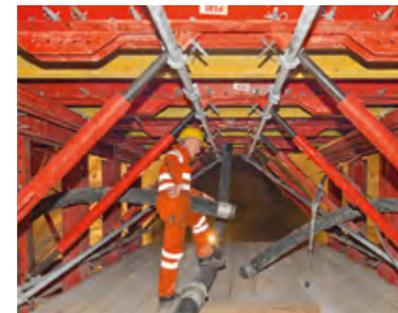
Die Fachwerkkonstruktion des Schalwagens bot eine gute Zugänglichkeit für alle erforderlichen Arbeiten.
