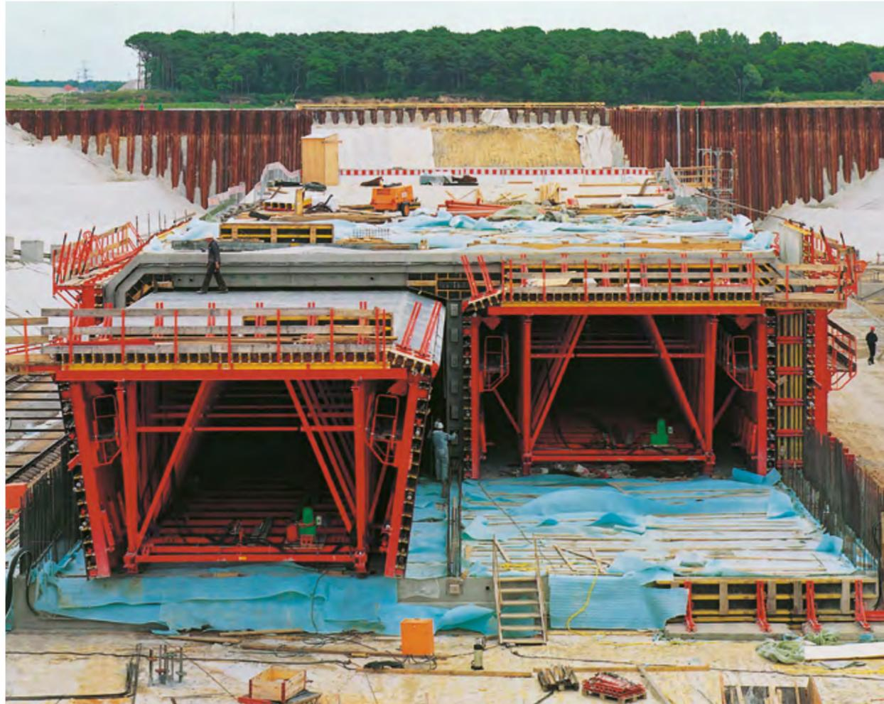
Der Bauherr – die Warnowquerung GmbH & Co. KG – schloss mit diesem Bauabschnitt den Tangentenring zur Umfahrung der Hansestadt. Der 790 m lange Tunnel wurde aus sechs Segmenten zusammengesetzt. Diese waren jeweils 120 m lang und wurden in acht Betonierabschnitten im Baudock vorgefertigt. Nach dem Verschließen der Kopfenden mit Stahltores und der Dockflutung folgte das Ausschwimmen der 22.000 t schweren Elemente.
