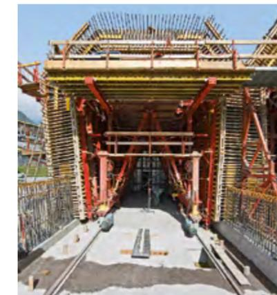
mussten. Für komfortables und schnelles Einschalen, Ausschalen und Verfahren waren die Wagen mit Elektroantrieb sowie einer hydraulischen Hub- und Absenkeinrichtung ausgestattet. Auch die polygonal montierten Außenschalungen auf Basis des VARIO GT 24 Träger-Wandschalungssystems ließen sich einfach an die unterschiedlichen Winkel anpassen. Der Bauablauf erfolgte von Norden nach Süden in jeweils 10 m langen Etappen.
