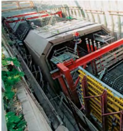
Schnell umsetzbar: HD 200 Schwerlaststützen waren verfahrbar an PERI UP Rosett Einheiten angeordnet. Sie bildeten die Notunterstützung und wurden unmittelbar nach dem Verziehen des Schalwagens eingebaut.
