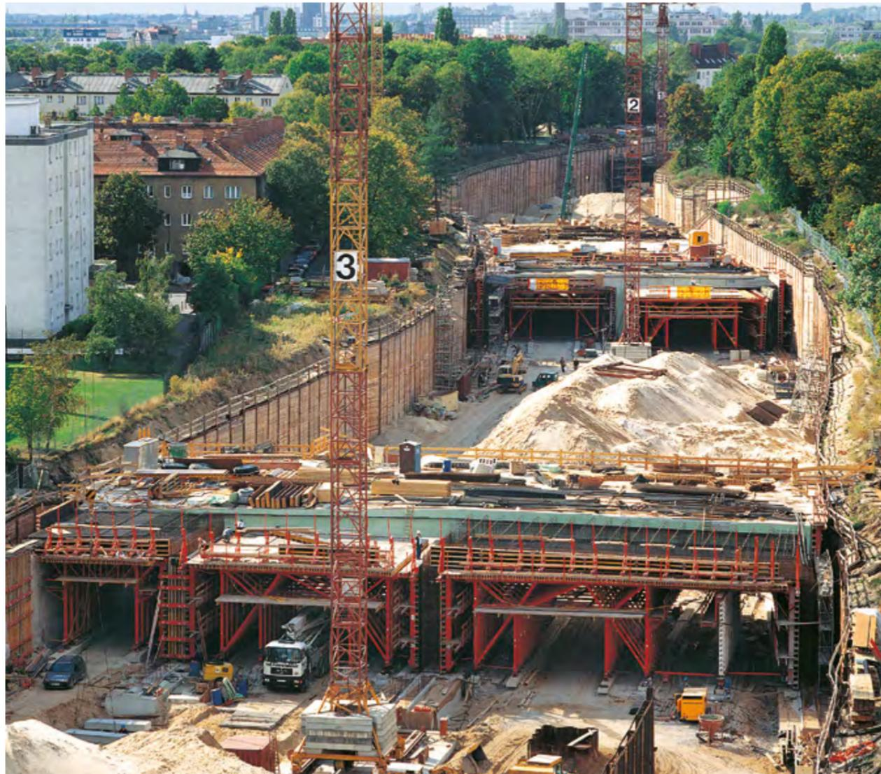
Das 1.000 m lange Teilstück für den Ausbau des Berliner Stadtrings Süd im Bezirk Neukölln wurde in offener Bauweise erstellt. Zwei Tunnelröhren bieten je drei Fahrspuren Platz. Im Verlauf der Strecke sind zwei Ausfahrten mit einer Breite von je 8,30 m integriert.
