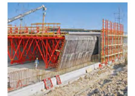
Nach dem hydraulischen Absenken und Einklappen der Wandschalung konnte der VARIOKIT Schalwagen schienengeführt in den nächsten Abschnitt verfahren werden.
