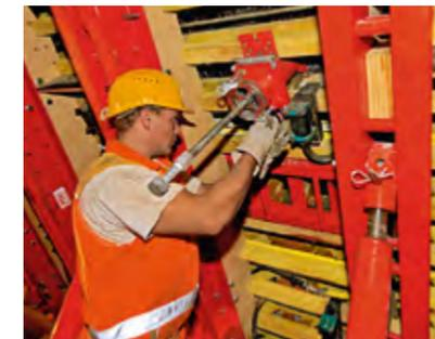
Für den Einbau des Betons wurden Betonpumpenanschlüsse BPA in die Schalungselemente integriert.
