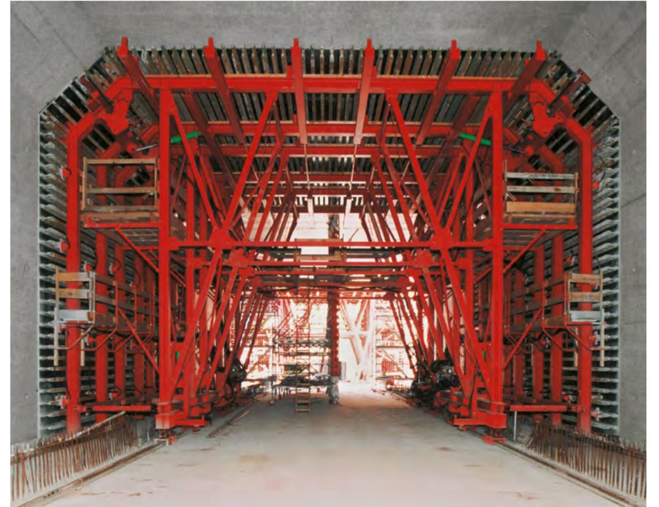
Innenschalwagen (Nachläufer) in Betonierstellung. Durch Ausfahren der Hydraulikzylinder angehoben und über Verschiebbalken mit Spindelbetätigung horizontal ausgerichtet.
