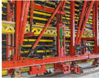
Die hydraulische Bedienbarkeit des VARIOKIT Schalwagens ermöglichte schnelles und wiederholungsgenaueres Ein- und Ausschalen.
