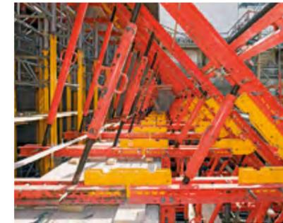
Geometrisch und statisch angepasste Gespärrekonstruktion mit PERI Systembauteilen: mithilfe von Universalkupplungen UK 70 biegesteif verbundene SRU Stahlriegel sowie SLS Schwerlastspindeln.
