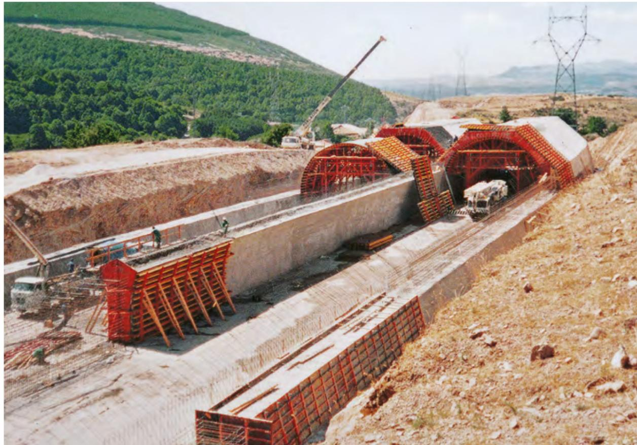
Zuerst wurden Mittelwand und Seitenwände hergestellt, das Gewölbe wurde anschließend auf Lücke betoniert: Ein erster Schalwagen läuft taktübergreifend voraus, ein zweiter Schalwagen schließt nachfolgend die Lücken. Auf diese Weise konnte der Baufortschritt erheblich beschleunigt werden.
