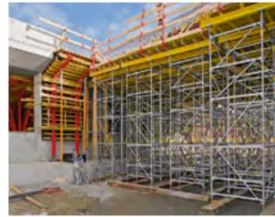
Modulare Traggerüstlösung mit PERI UP Rosett für Stiehlasten bis zu 40 kN – typengeprüft, anpassungsfähig und einfach zu montieren.
