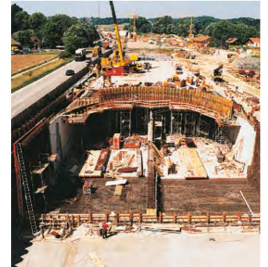
Die Formgebung an den beiden Einfahrtsbauwerken war äußerst kompliziert. Mit der stufenlos einstellbaren RUND-FLEX Rundschalung und werkseitig montierten Auffütterungen konnte diese Konstruktion mit gutem Ergebnis umgesetzt werden. Bis zu 140 Richtstützen nahmen den einseitigen Schalungsdruck in der Rundung auf.
