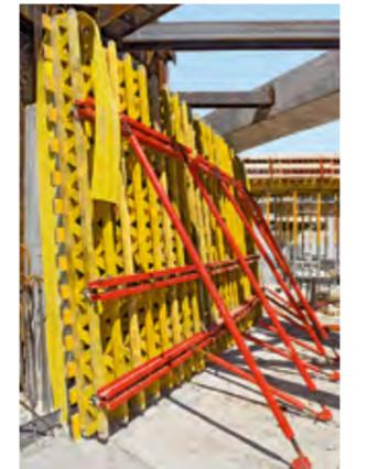
Mit maßgenau vorgefertigten VARIO GT 24 Schalungselementen wurden die geneigten Kreiselaußenwände in Sichtbetonqualität hergestellt.
