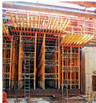
Die Notunterstützung aus MULTIPROP Stützen und MRK Rahmen ließ sich schnell montieren.
