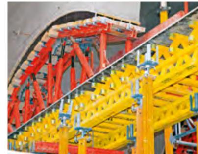
Auch die Bogenschalung und die tragende Unterkonstruktion für die massiven, 80 cm breiten Stahlbetonrippen basierte auf mietbaren Systembauteilen: Eingesetzt wurden GT 24 Gitterträger, SRU Stahlriegel, SLS Schwerlastspindeln und MULTIPROP Deckenstützen.
