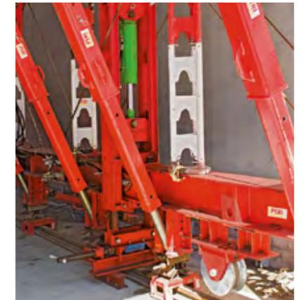
Mit der Hub- und Absenkeinrichtung konnten die Deckenschalwagen hydraulisch in Betonierposition gehoben und wieder abgesenkt werden.
