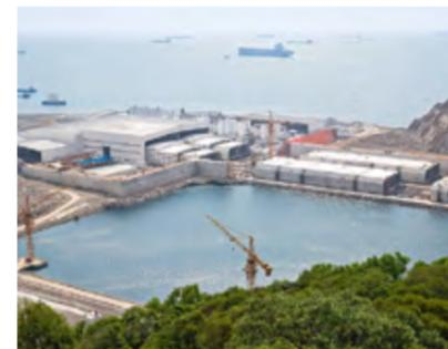
Die 180 m langen Tunnelröhren werden von der Feldfabrik in ein Trockendock verschoben, mit Schottwänden verschlossen, gewässert und zur finalen Position geschleppt.
