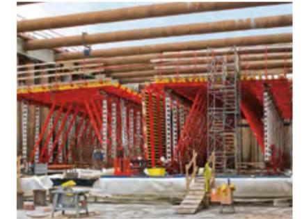
Tunnelschalwagen auf der Basis des VARIOKIT Ingenieur-baukastens für die sechs zusätzlichen, zeitgleich auszuführenden Betonierabschnitte am Südportal.
