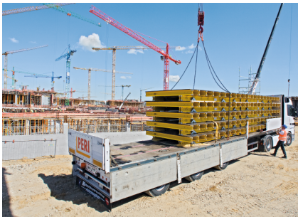
Transparente Nachverfolgbarkeit durch aktives Tracking der Produkte vom Lager auf die Baustelle und zurück
